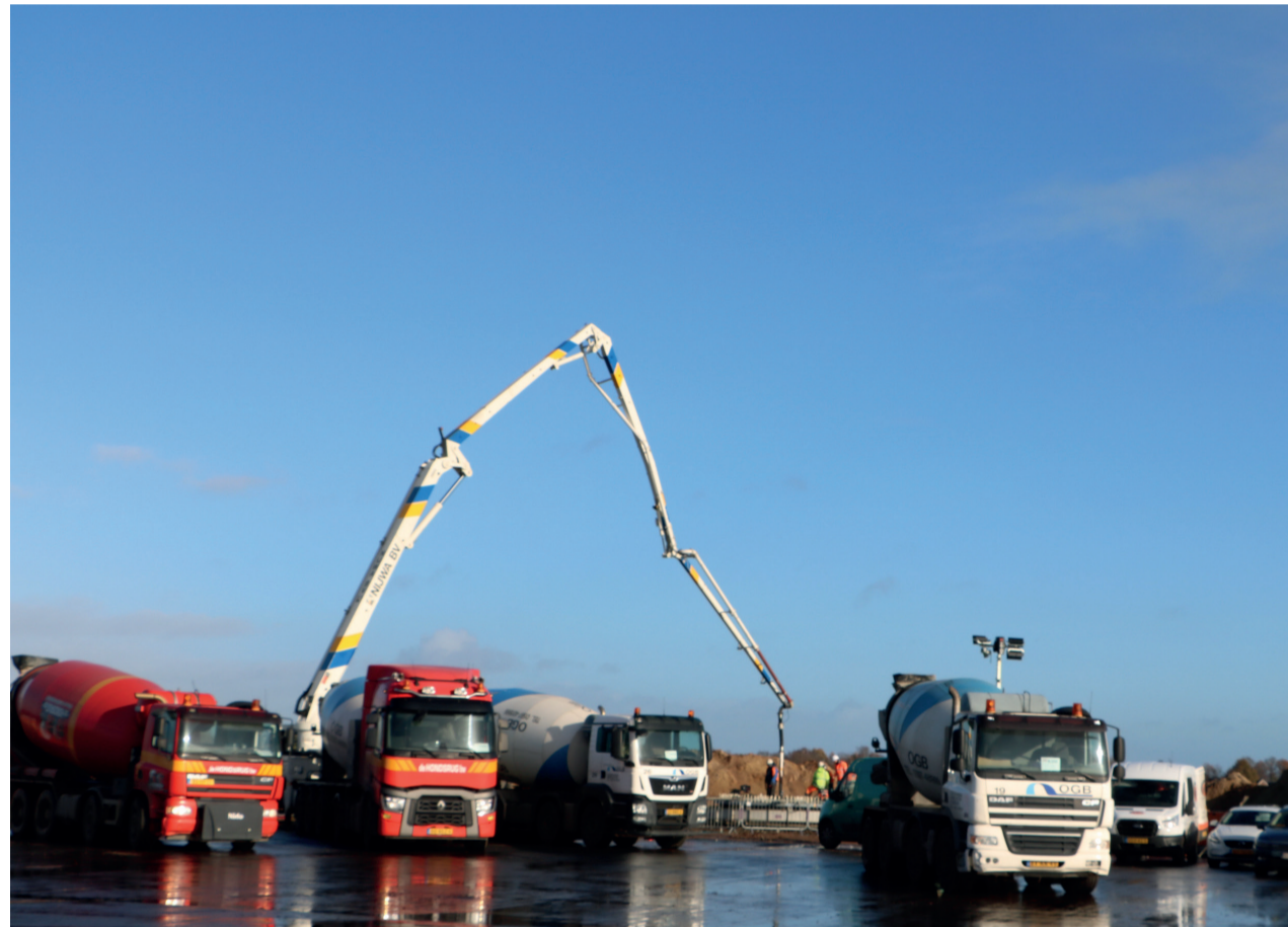
Storten van beton voor de funderingen: ook een logistieke uitdaging waarbij per dag zo'n vijftig betonmixers hun lading aanvoerden om aansluitend het beton te kunnen storten.
